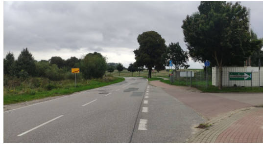
Pinnower Straße, Blickrichtung Osten, Zufahrt Neubaugebiete Wohnpark Laage
