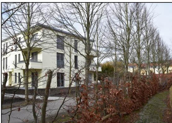
nordwestlich angrenzende Geschosswohngebäude des „Wohnparks Hanshäger Straße“
