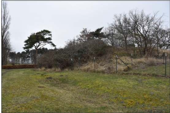
mit Erdreich angeschütteter ehem. Druckwasserbehälter
