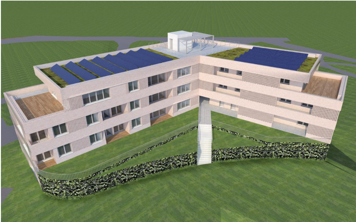
Abbildung 11: Gebäudeansicht aus der südlichen Luftperspektive
