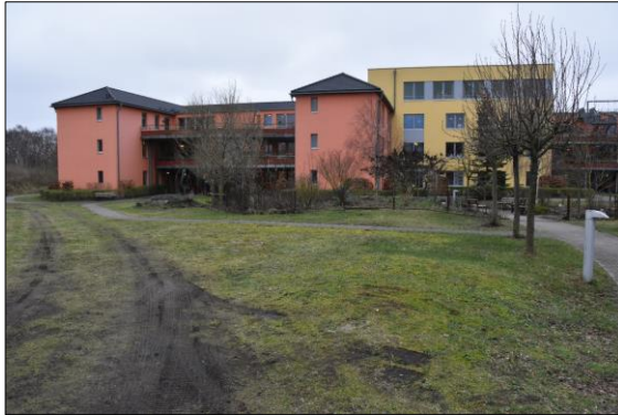
Zierrasen im nördlichen Wohnumfeld der DRK-Wohnanlage
