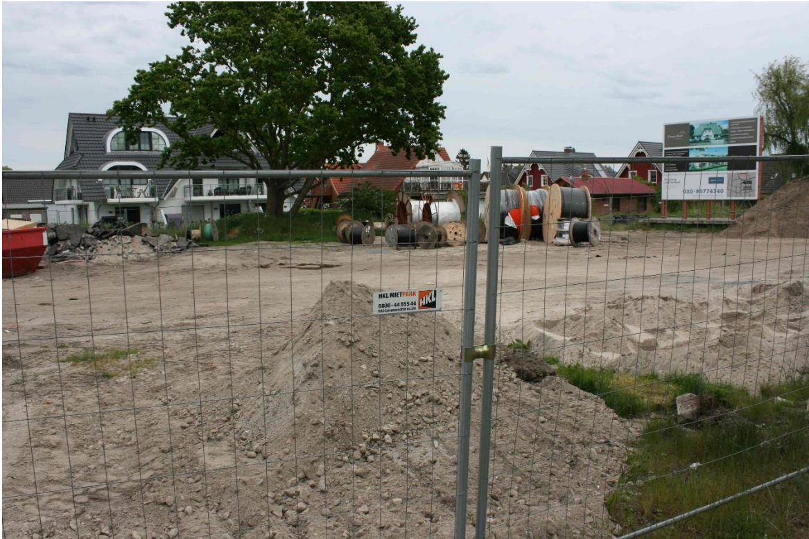
Abbildung 9: Mittlerer Teil des Untersuchungsgebiets, als Lagerfläche für Sand, Kabeltrommeln und diverse Bauabfälle genutzt, ohne erkennbare Lebensraumpotenziale für artenschutzrechtlich relevante Tier- und Pflanzenarten
