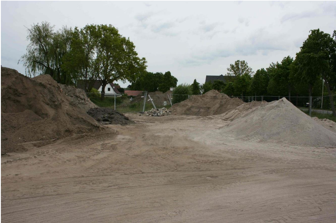
Abbildung 11: Südlicher Teil des Untersuchungsgebiets, als Zwischenlagerfläche für Boden und Sand genutzt, ohne erkennbare Lebensraumpotenziale für artenschutzrechtlich relevante Tier- und Pflanzenarten
